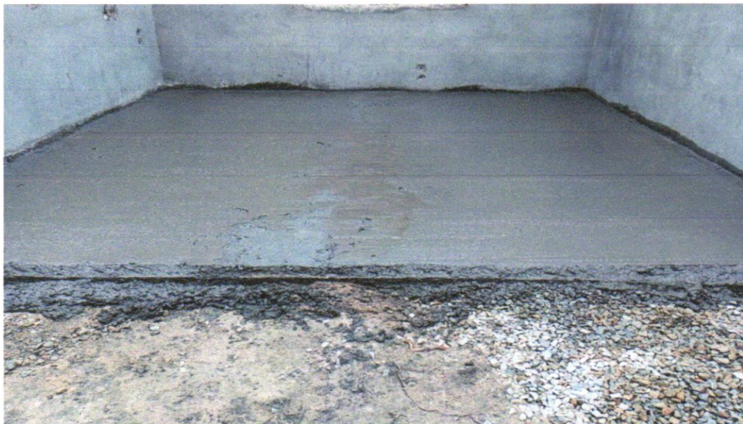
FOTO 21 - PISO EM CONCRETO 20 MPA PREPARO MECÂNICO, ESPESSURA 7CM. AF_09/2020
