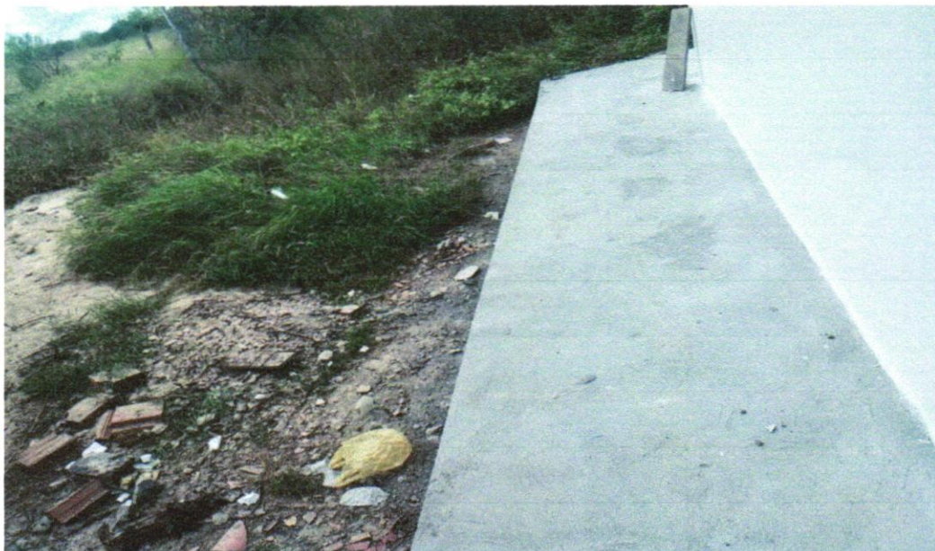
FOTO 23 - EXECUÇÃO DE PASSEIO (CALÇADA) OU PISO DE CONCRETO COM CONCRETO MOLDADO IN LOCO, USINADO, ACABAMENTO CONVENCIONAL, NÃO ARMADO. AF_07/2016
