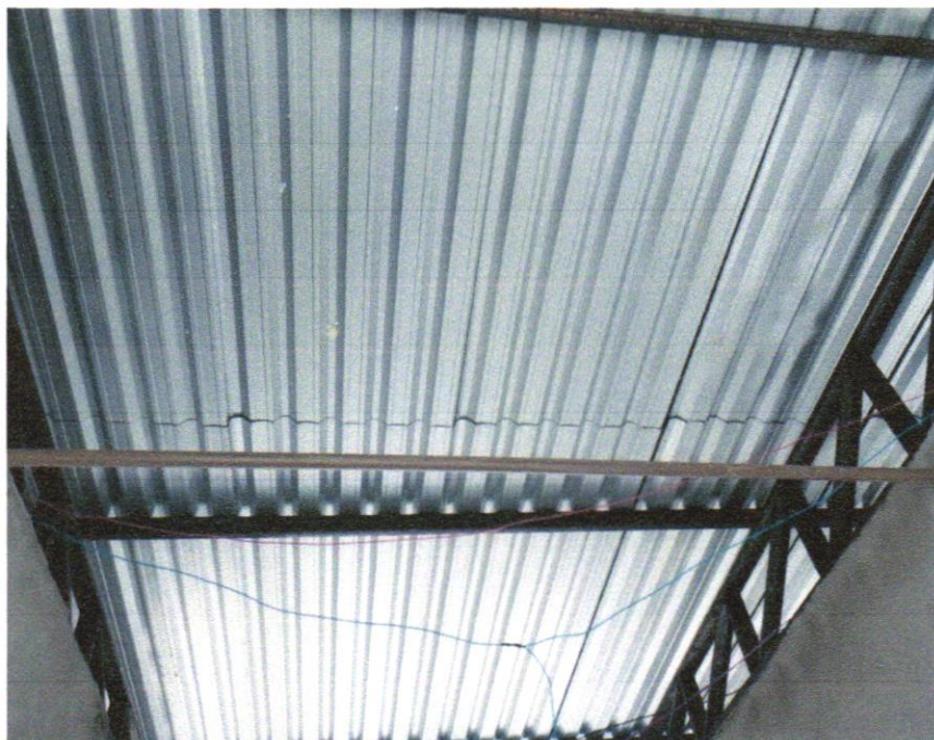
FOTO 05 – TELHAMENTO COM TELHA METÁLICA TERMOACÚSTICA E = 30 MM, COM ATÉ 2 ÁGUAS, INCLUSO IÇAMENTO. AF_07/2019
