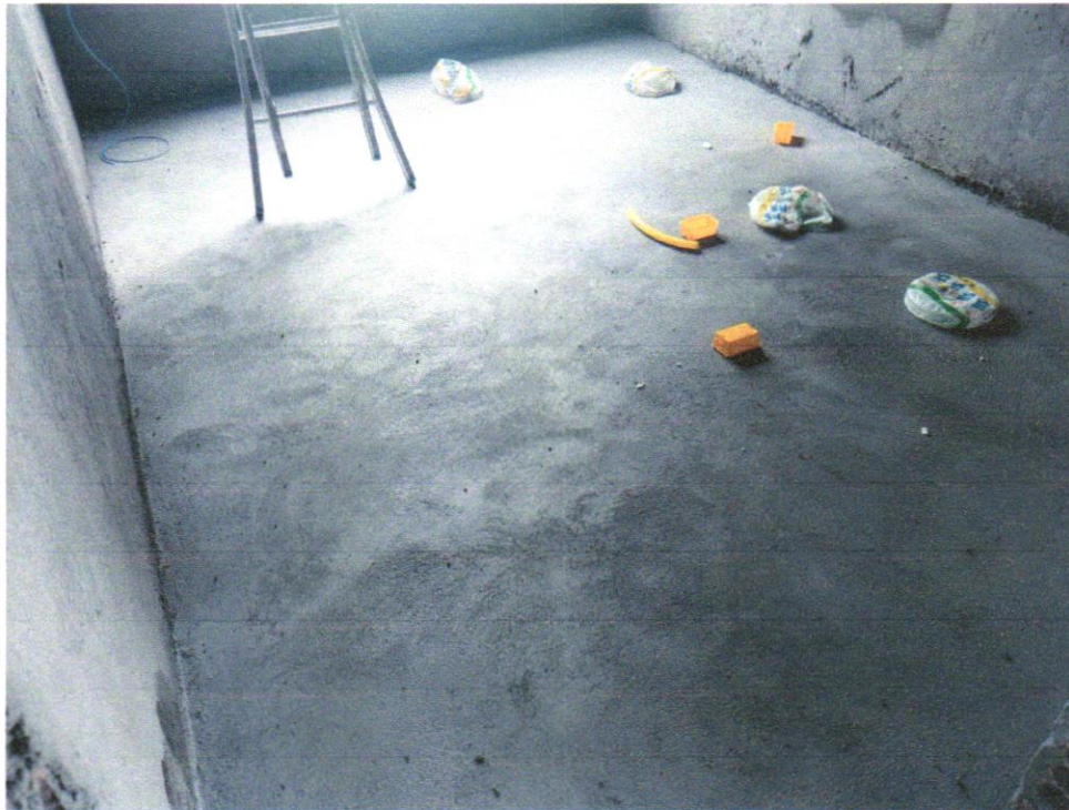
Foto 26 - (COMPOSIÇÃO REPRESENTATIVA) DO SERVIÇO DE CONTRAPISO EM ARGAMASSA TRAÇO 1:4 (CIM E AREIA), EM BETONEIRA 400 L, ESPESSURA 3 CM ÁREAS SECAS E 3 CM ÁREAS MOLHADAS, PARA EDIFICAÇÃO HABITACIONAL UNIFAMILIAR (CASA) E EDIFICAÇÃO PÚBLICA PADRÃO. AF_11/2014
