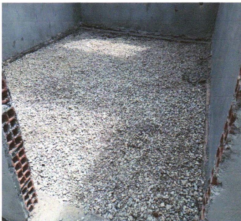
Foto 18 - Lastro de brita graduada apilada e=10cm
