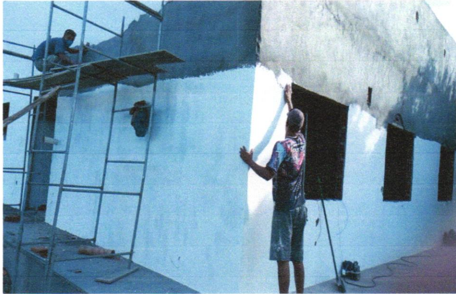
Foto 25 - APLICAÇÃO E LIXAMENTO DE MASSA LÁTEX EM PAREDES, UMA DEMÃO. AF_06/2014
