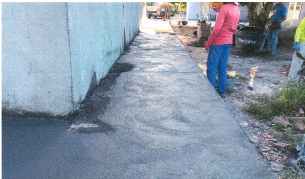
Foto 22 - EXECUÇÃO DE PASSEIO (CALÇADA) OU PISO DE CONCRETO COM CONCRETO MOLDADO IN LOCO, USINADO, ACABAMENTO CONVENCIONAL, NÃO ARMADO. AF_07/2016
