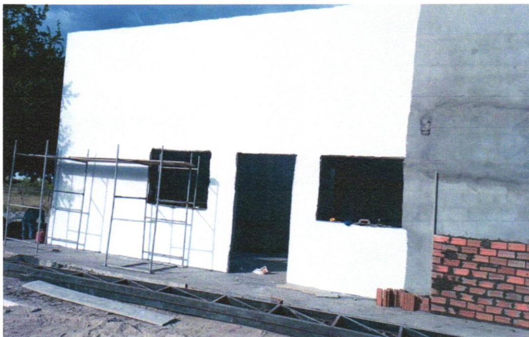
Foto 24 - APLICAÇÃO E LIXAMENTO DE MASSA LÁTEX EM PAREDES, UMA DEMÃO. AF_06/2014
