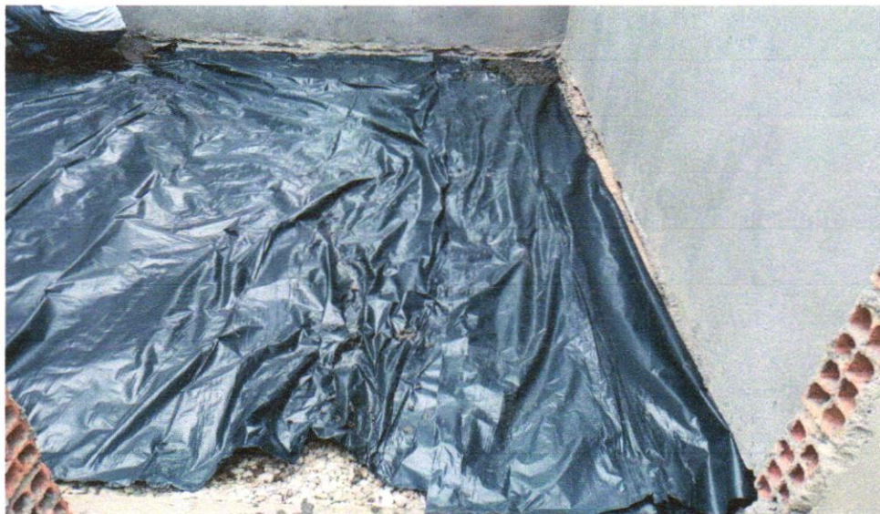
Foto 19 - APLICAÇÃO DE LONA PLÁSTICA PARA EXECUÇÃO DE PAVIMENTOS DE CONCRETO. AF_04/2022
