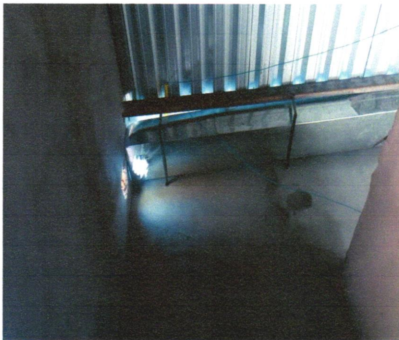
Foto 09 - CALHA EM CHAPA DE AÇO GALVANIZADO NÚMERO 24, DESENVOLVIMENTO DE 100 CM, INCLUSO TRANSPORTE VERTICAL. AF_07/2019
