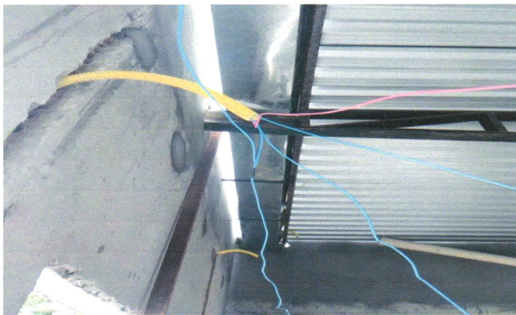
Foto 12 - CABO DE COBRE FLEXÍVEL ISOLADO, 1,5MM 2 , ANTICHAMA 0,6/1,0KV, PARA CIRCUITOS TERMINAIS - FORNECIMENTO E INSTALAÇÃO. AF_12/2015
