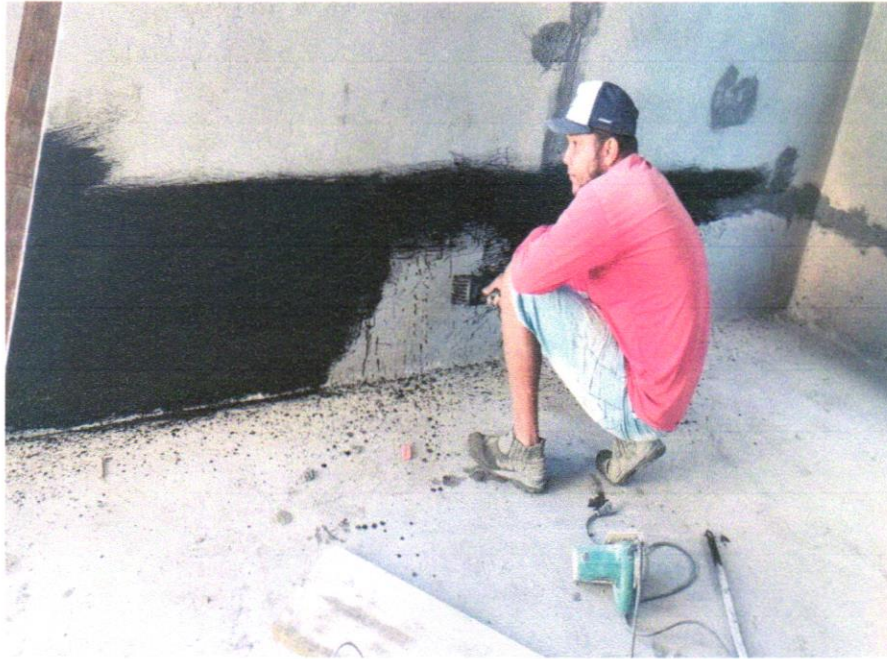
Foto 15 - IMPERMEABILIZAÇÃO DE SUPERFÍCIE COM MANTA ASFÁLTICA, UMA CAMADA, INCLUSIVE APLICAÇÃO DE PRIMER ASFÁLTICO, E=3MM. AF_06/2018
