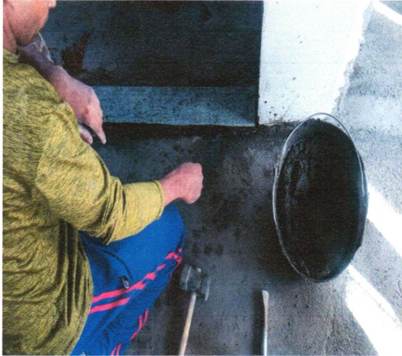
FOTO 07 - SOLEIRA EM GRANITO, LARGURA 15 CM, ESPESSURA 2,0 CM. AF_09/2020
